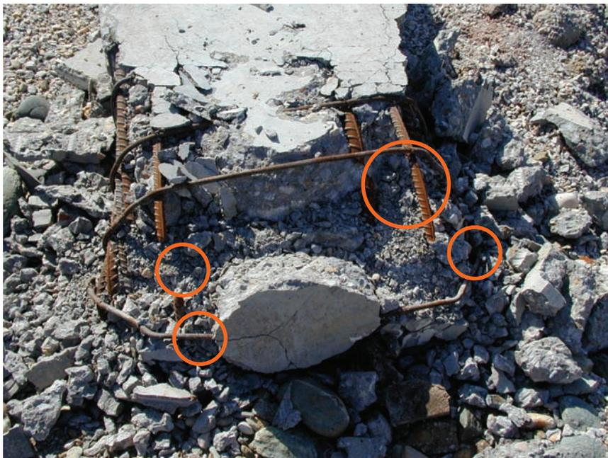
Foto 3.1 Fallo producido por la insuficiente ductilidad del acero longitudinal del pilar
