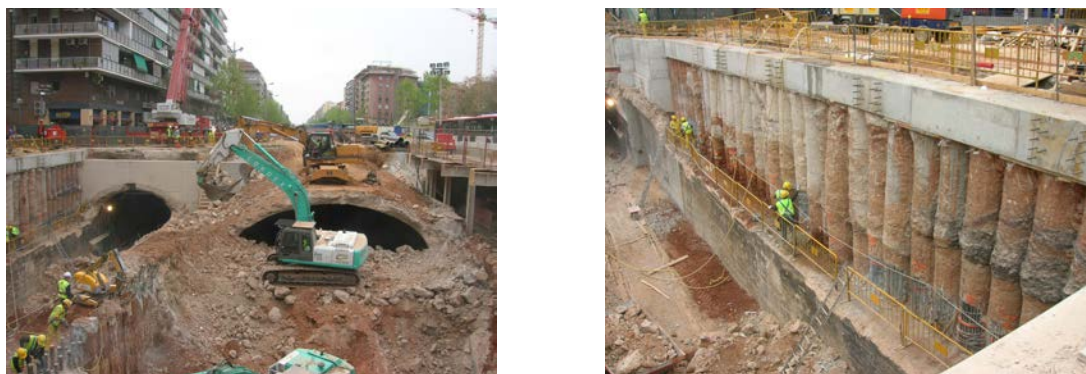
Figura 5.2.- Obras para el intercambiador de la Sagrera. (Barcelona)
