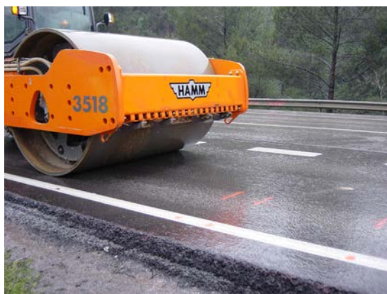
Figura 4.34.- Carga del pavimento mediante rodillo
