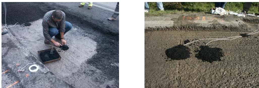
Figura 4.31.- Colocación de galgas sobre pavimento existente
