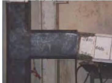
(c) Rótula plástica en el extremo donde finaliza el refuerzo en la viga [64]
