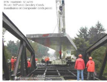
(b) Sustitución de tablero de puente
