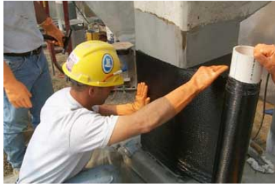
(a) Refuerzo estructural
