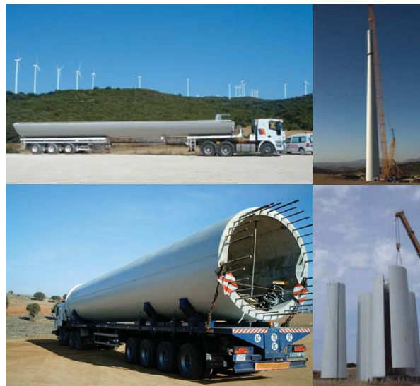
Figura 4-1. Torres prefabricadas de hormigón reforzado de 100 m de altura. Fuente de las fotos [9]. Figura tomada de [2].
