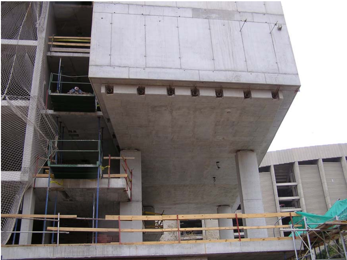
Foto 7.8 Estructura singular, forjado postensado sobre juntas de neopreno.
