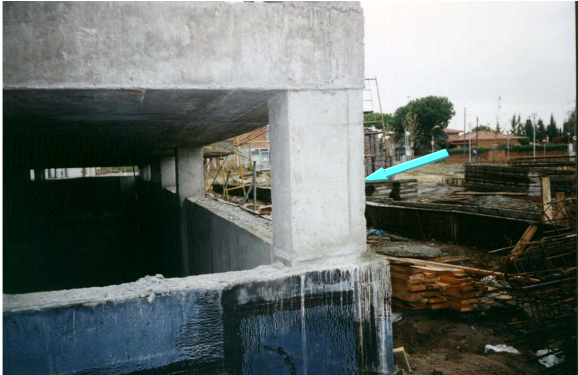
Foto 7.5 Pilares cortos en edificio.
