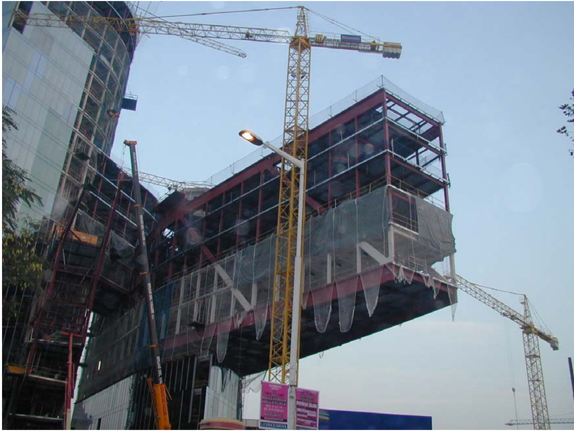
Foto 7.9 Estructura singular, pórticos de acero en voladizo.
