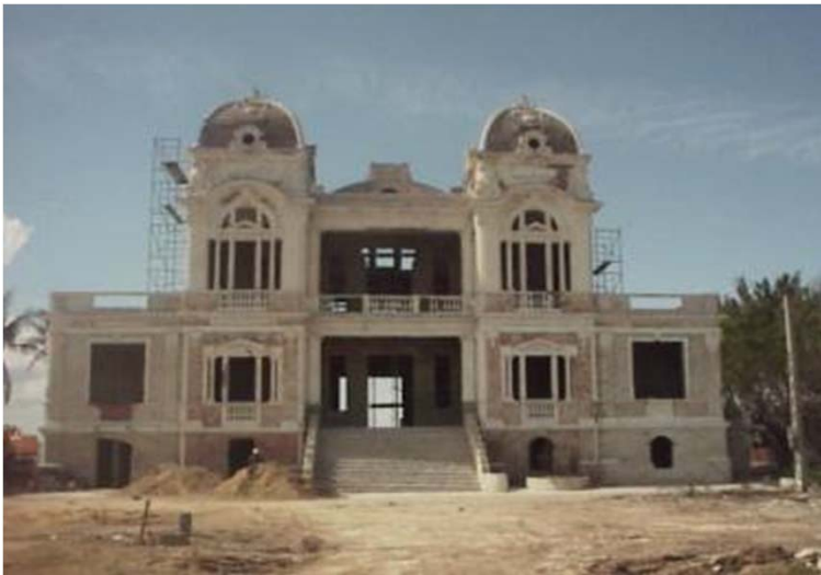
Yacht Club, Cienfuegos (cúpula con problemas técnicos)
