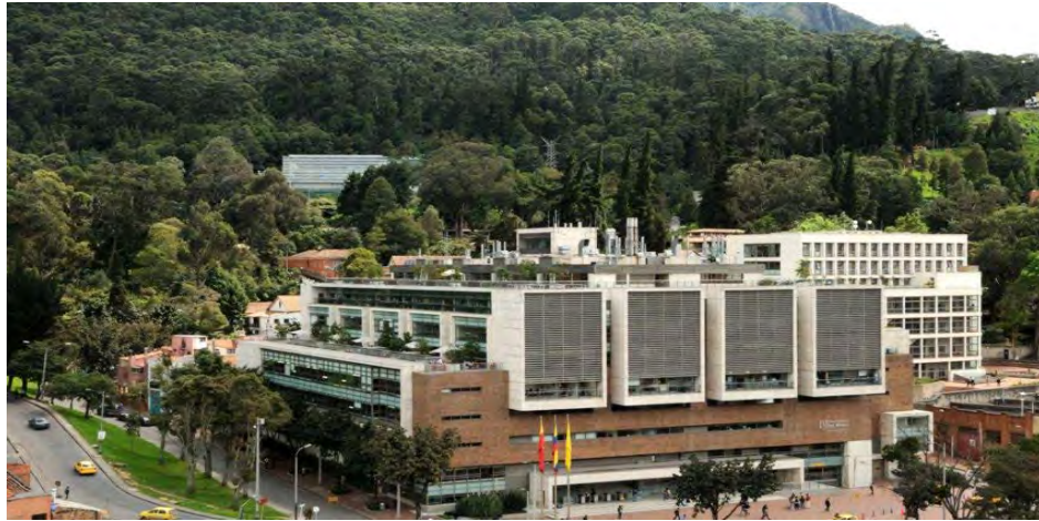
Figura 124: Ubicación del Aula UNLANDES-CIMNE.
