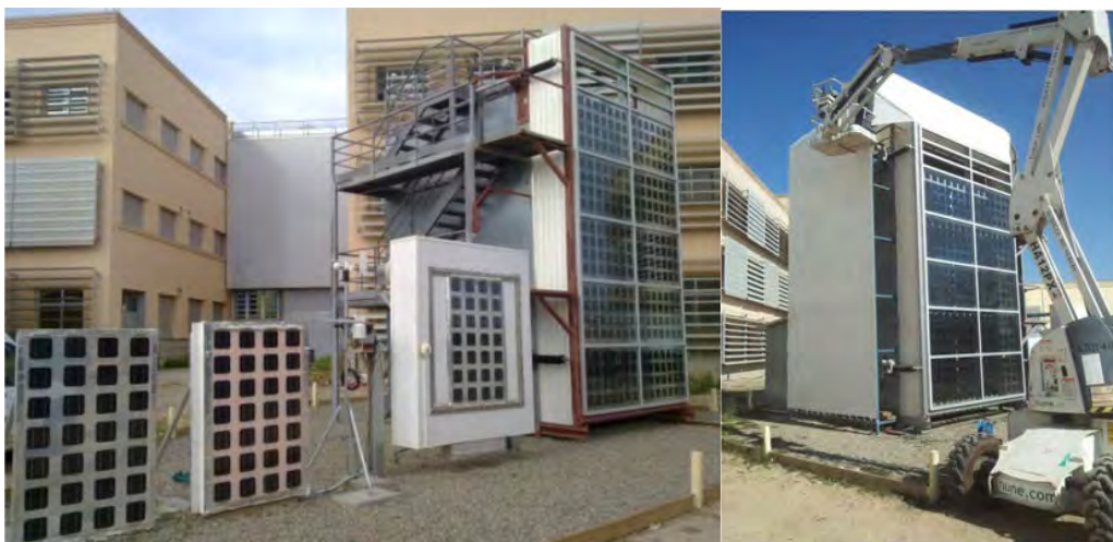
Figura 24: Instalación para el ensayo y medida de fachadas Fotovoltaicas Integradas en edificios.
