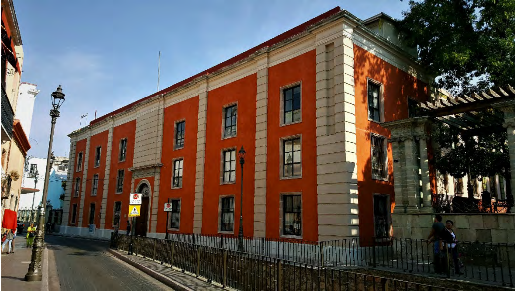
Figura 142: Ubicación del Aula UGTO-CIMNE.
