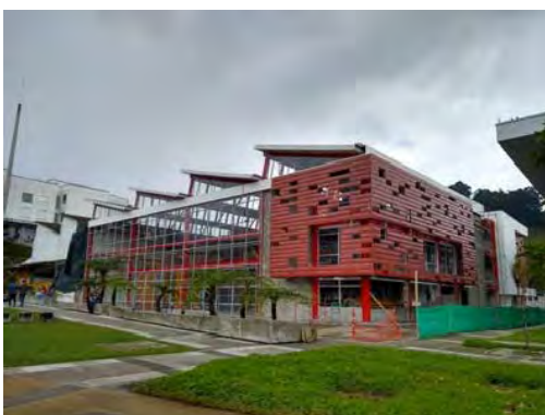
Figura 121: Edificio del laboratorio de Estructuras.
